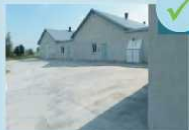
Забетонированная окружающая зона
