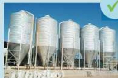
Силосы в хорошем состоянии
