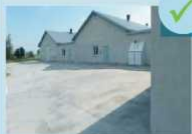
Забетонированная окружающая зона
