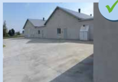
Забетонированная окружающая зона
