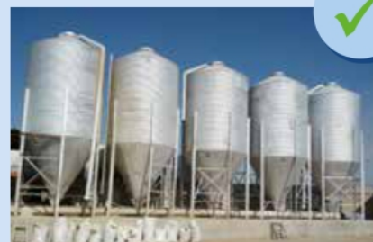
Силосы в хорошем состоянии
