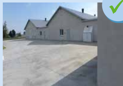
Забетонированная окружающая зона
